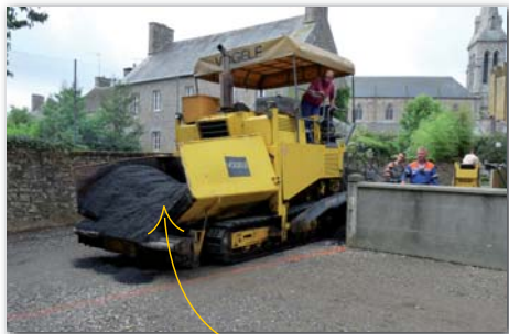
28 août, pose de l'enrobé à chaud
