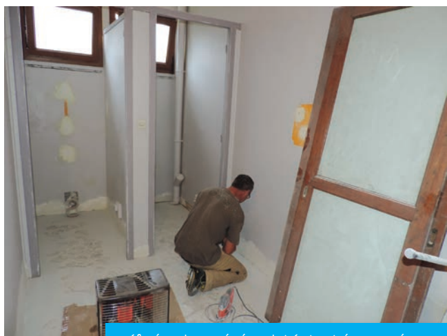
Réfection des sanitaires de l'école Alain-Fournier
